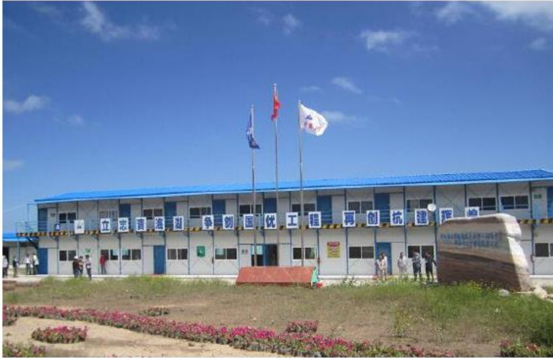
为提升河南分公司管理队伍的专业素质,创新管理思路,为公司工程项目精细化管理工作提供强有力的支持,8月15日-8月18日,河南分公司一行26人,由副经理唐建五带队,赴青海分公司青海湖二郎剑景区观海酒店工程施工项目进行了参观学习。
